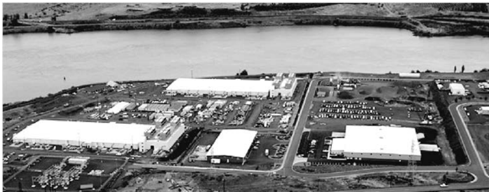
Rysunek 2.1. Zdjęcie przedstawia ściśle tajne centrum danych Google w miejscowości Dalles w Oregonie, zbudowane w pobliżu tamy w celu uzyskania dostępu do taniej energii. Zwróć uwagę na duże chłodnie kominowe na końcach znajdujących się po lewej stronie zdjęcia budynków wielkości boiska do futbolu. Kominy chłodzą budynki przez parowanie, bez używania kosztownych energetycznie chłodziarek. Źródło: Melanie Conner, „New York Times”
